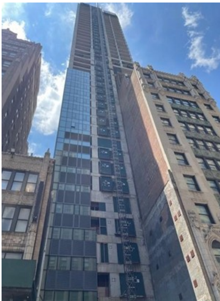
原商业计划收录的施工照片
